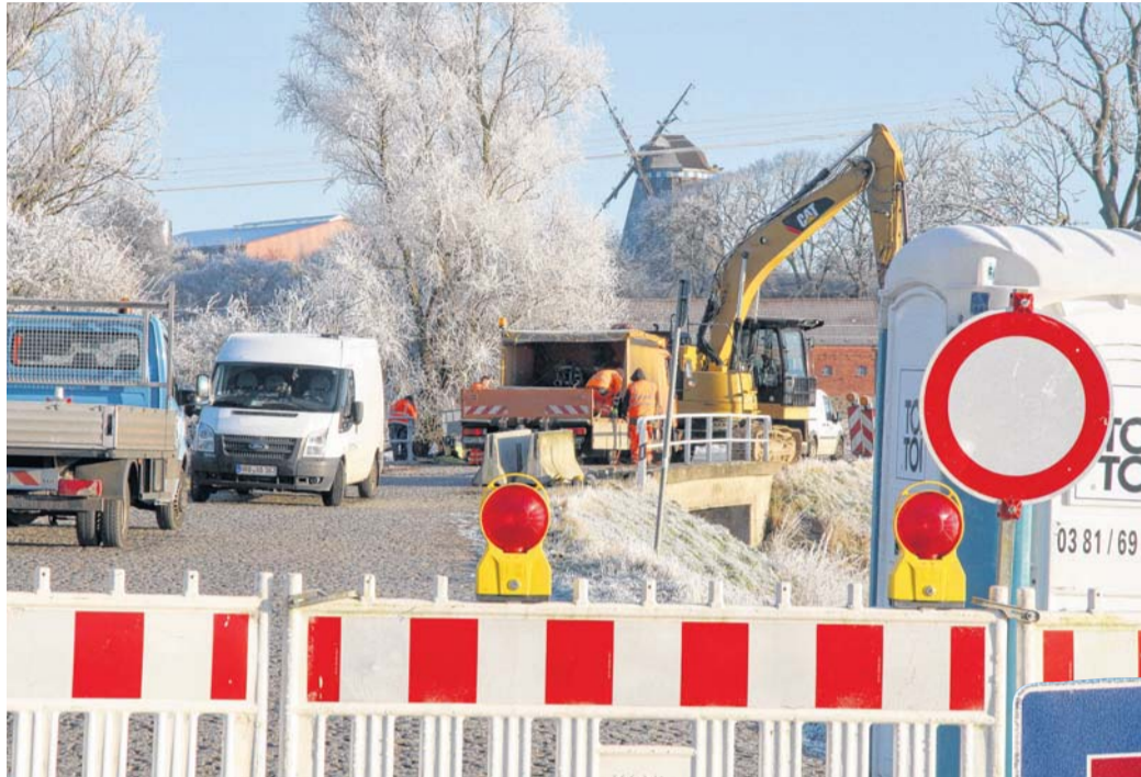
Hier haben jetzt die Handwerker das Sagen: Als erstes wurden gestern Morgen die massiven Sperranlagen im Brückenbereich demontiert und abtransportiert, um Baufreiheit für die Abrisskommandos zu schaffen.
