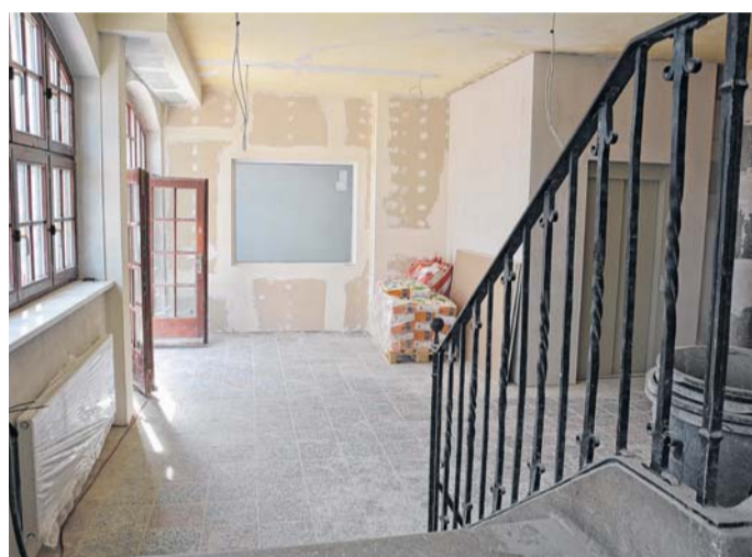
Das wird der neue Eingangsbereich des Wohnparks „Alte Schule“. Über einen Fahrstuhl beziehungsweise die Treppe geht es zu den fünf altersgerechten Wohnungen und 28 Servicewohnungen.
