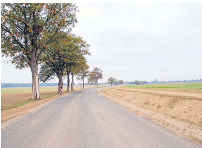
Bis auf die Straßenmarkierung ist die Strecke zwischen Wilhelminenthal und Unnode fertiggestellt.
